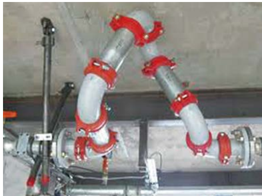
지진분리장치의 예시 국민안전처 내진설계 화재안전기준 해설서 사진사용
