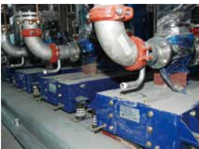
펌프 방진 설치
